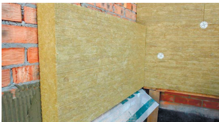
Рисунок 1. Утепление фасада минераловатными плитами
