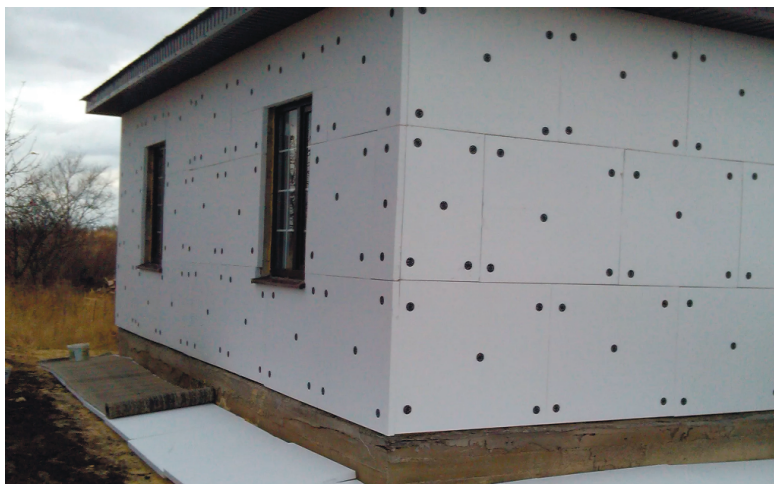
Рисунок 2. Утепление фасада ЭППС
